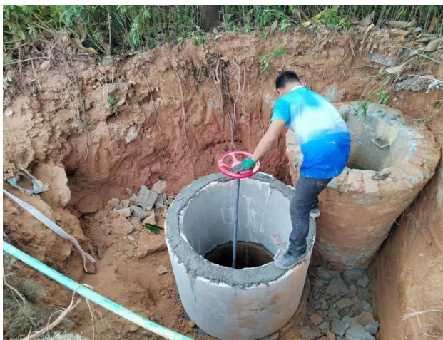
园区总出水口雨水截止阀门
