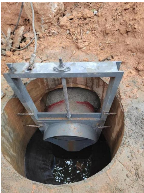
园区总出水口雨水截止阀门
